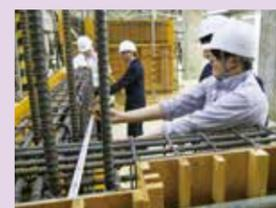
躯体工事エリアでは、鉄筋工事と型枠工事の施工状況を学びます。基本となる主要構造部の柱梁をはじめ、基礎部分の配筋について実物を使って研修します。また仮設足場に触れ、安全環境を学びます。
